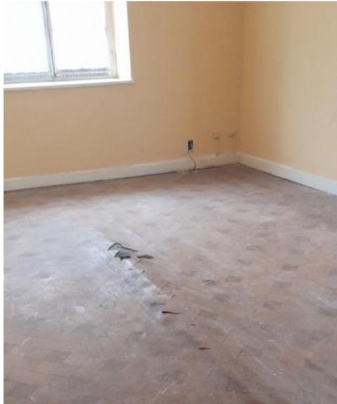
La planta alta está construida con entrepisos de madera sobre vigas de madera apoyadas en los muros portantes (sobre el ingreso) y embovedados de ladrillo con entablonado sobre el que se pegó una alfombra.
