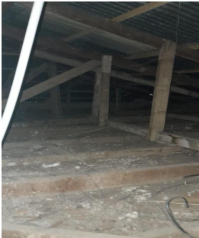
Los cielos son falsos de yeso sobre malla y paja adosados a los contrapisos o a la estructura de cubierta.
