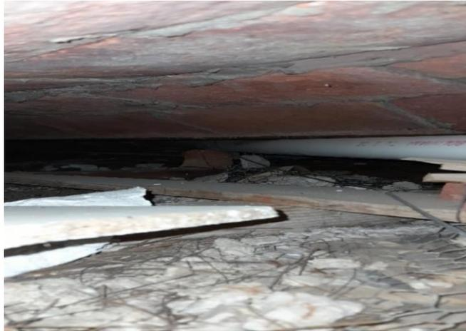
Las cubiertas tienen estructura de madera, un revestimiento de calamina sobre el que se realizó el revestimiento de teja colonial.
