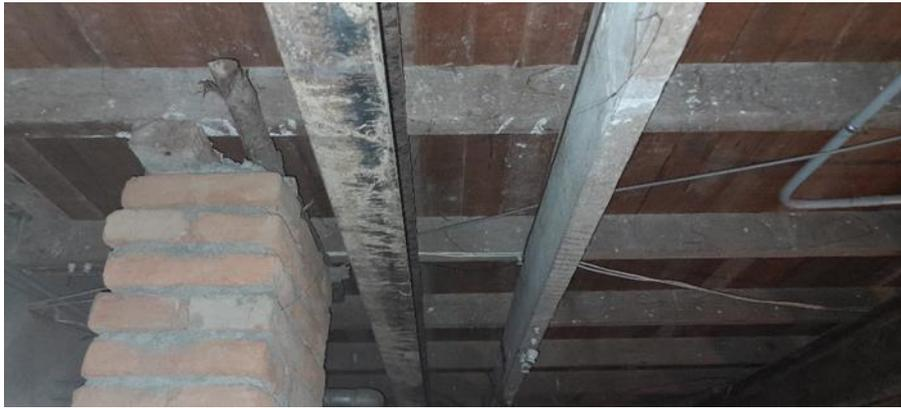
Sobre el entablonado de madera original se colocó una capa de cartón asfáltico, una capa de revestimiento de corcho y sobre ella se pegaron pisos de parquet de madera deteriorados en varios sectores.
