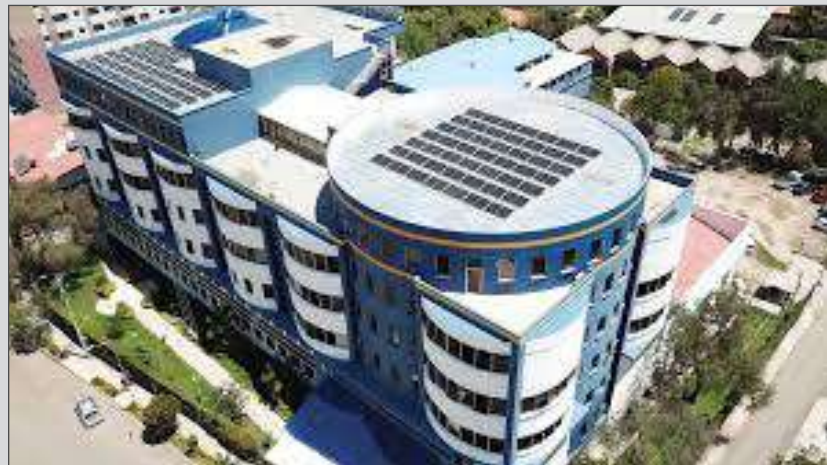
Foto N°144. Edificio Modelo Universitario con paneles solares
